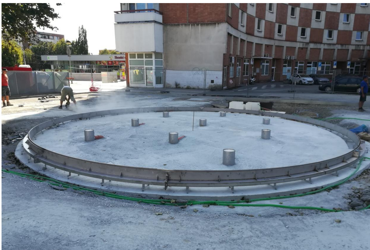
Zlín - provádění fontány - usazení lemu a nádržek trysek, provedení podkladní beton nad rozvody
