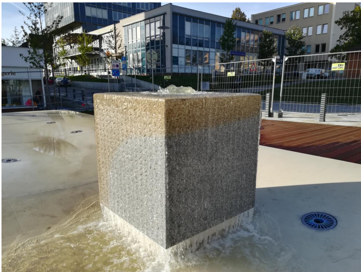
Praha (centrum Krakov) - hladká betonová plocha fontány, nerezové mřížky trysek integrované do plochy
